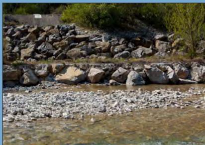
Sur le Grand Buëch, la semelle\* de cette digue, normalement enfoui sous le lit du cours d'eau, a été mis à jour du fait de l'enfoncement du lit. La stabilité de la digue est alors menacée. Plus encore que l'inondation, la destruction des ouvrages de protection des crues suite à l'enfoncement du lit est un facteur de risque important sur le bassin versant du Buëch.
